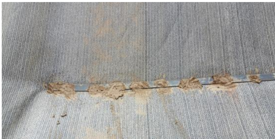
Figure 14. Détail des ancrages intermédiaires avec ajout de pâte bentonitique pour garantir l'étanchéité
