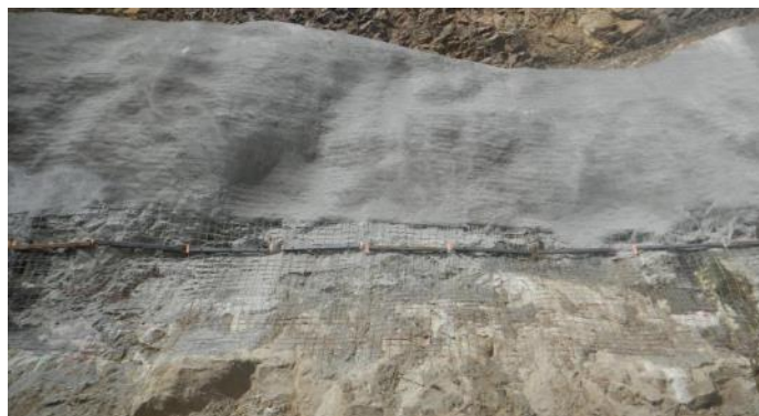
Figure 12. Profils métalliques dans le parement pour ancrage du GSB
