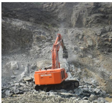
Figure 2. Travail au brise roche hydraulique (BRH) sur l'andésite en parement
