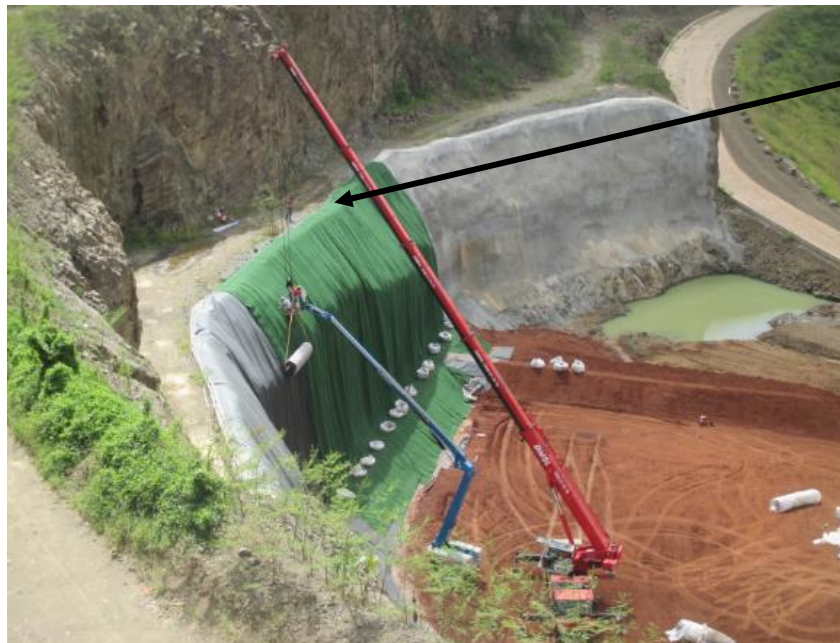
Figure 13. Méthodologie de mise en œuvre par le haut du talus
