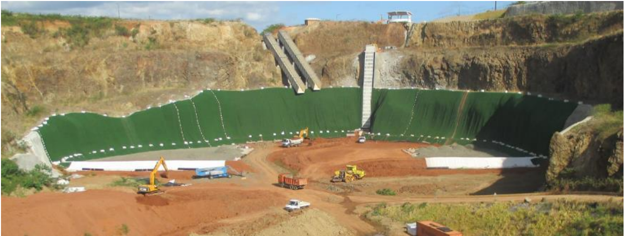
Figure 15. Calepinage sur mesure du géocomposite de drainage anti-UV
